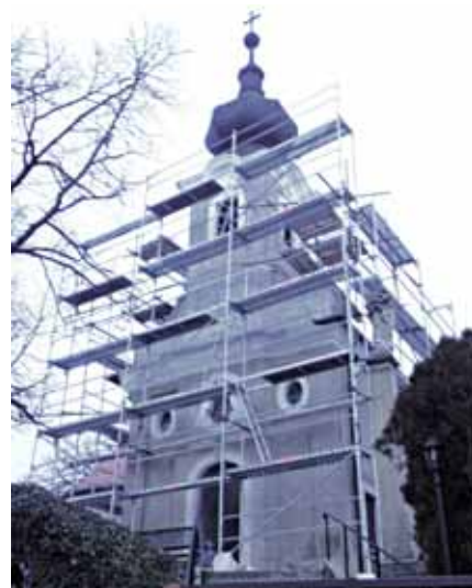
• Katolícky kostol v Koptovciach prechádza rekonštrukciou.
