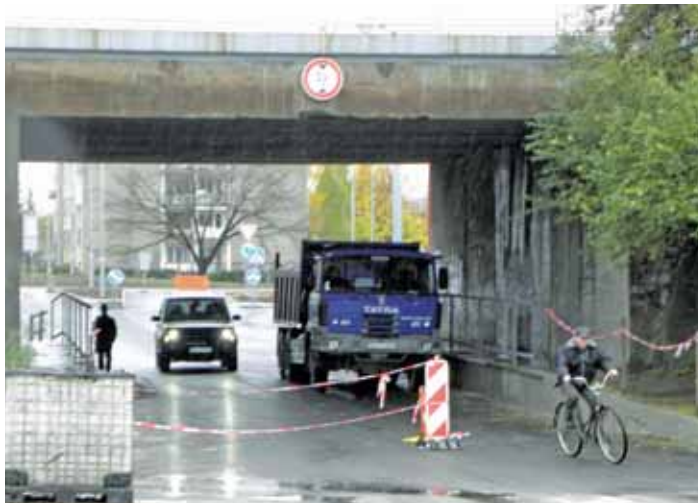
● Železničný podjazd sprejzdnia vo štvrtok. Nový asfalt však lákal vodičov porušovať dopravné predpisy oveľa skôr.
